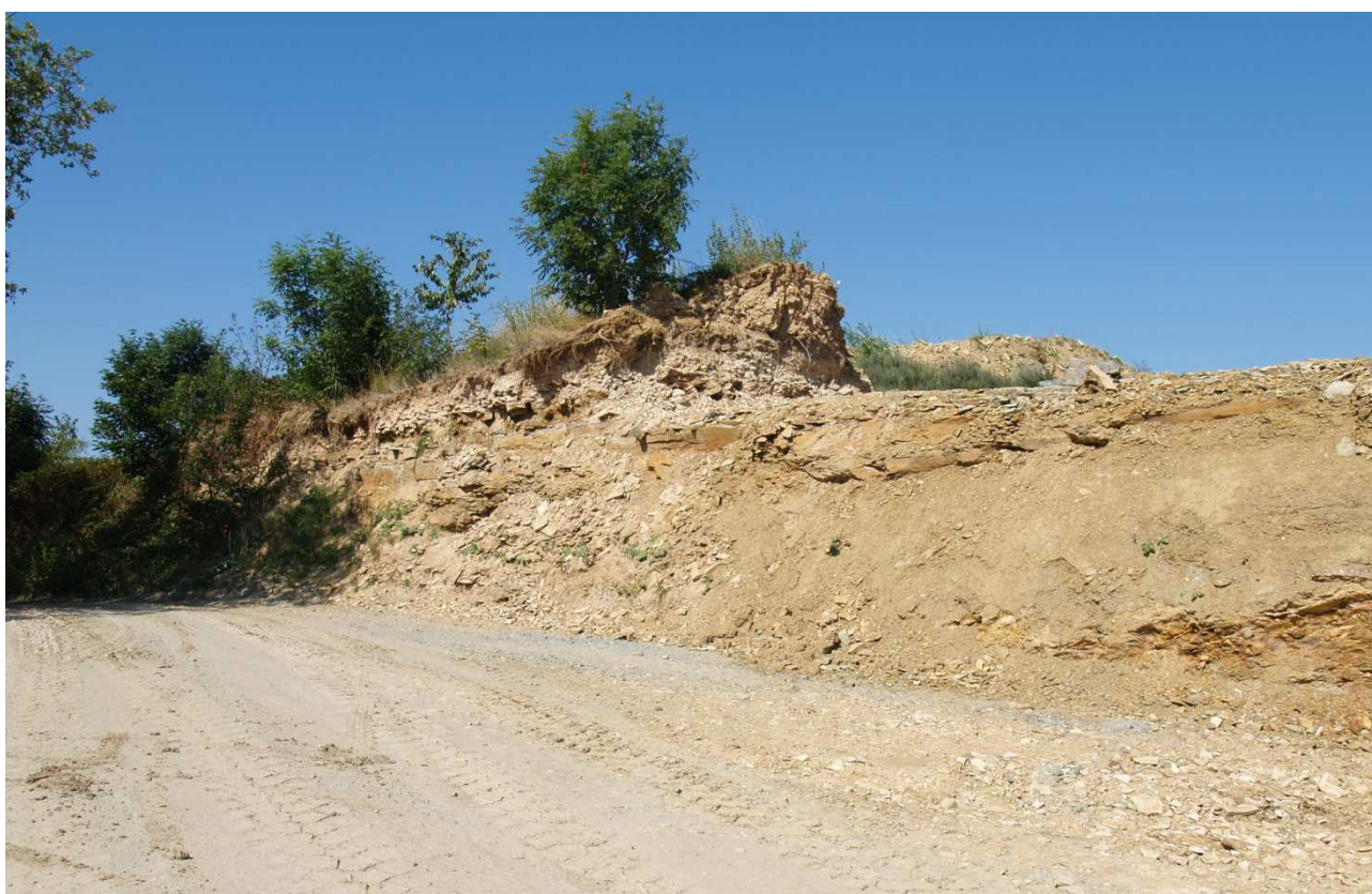
Obrázek 14 - Nadložní křídové sedimenty v zářezu u odvalu v Mastech. Foto T. Zemánková
